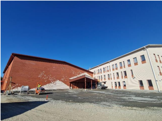
Kuva Pääsisäänkäynnin edustan pihatöitä
