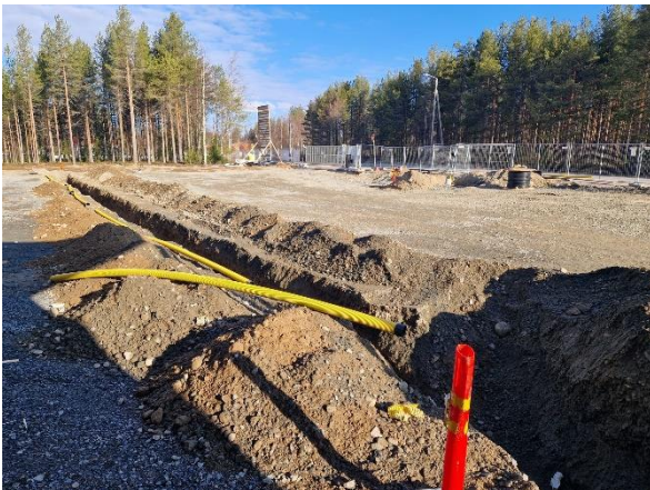
Kuva pihan kaapelointityöt jatkuvat
