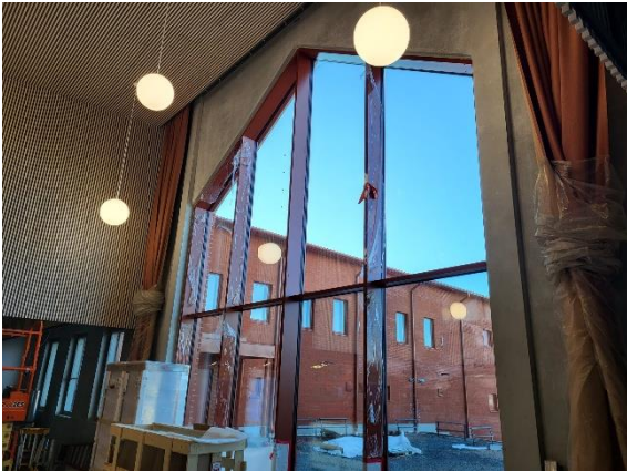
Kuva Ruokalan verhoasennukset
