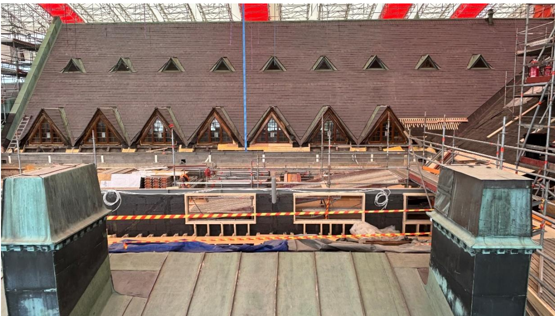
Kuva 7. Lapetelineet purettu Kansantieteellisen osan länsipuolelta.
