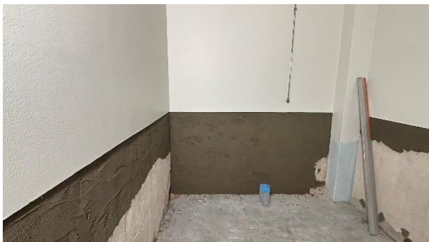
Kuva 3. Esteettömän wc:n seinien tasoitusta, ennen laatoitusta.
