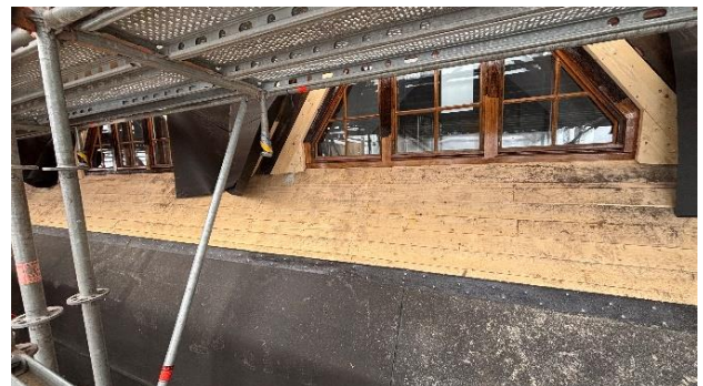
Kuva 4. Vesikaton puukorjauksia.
