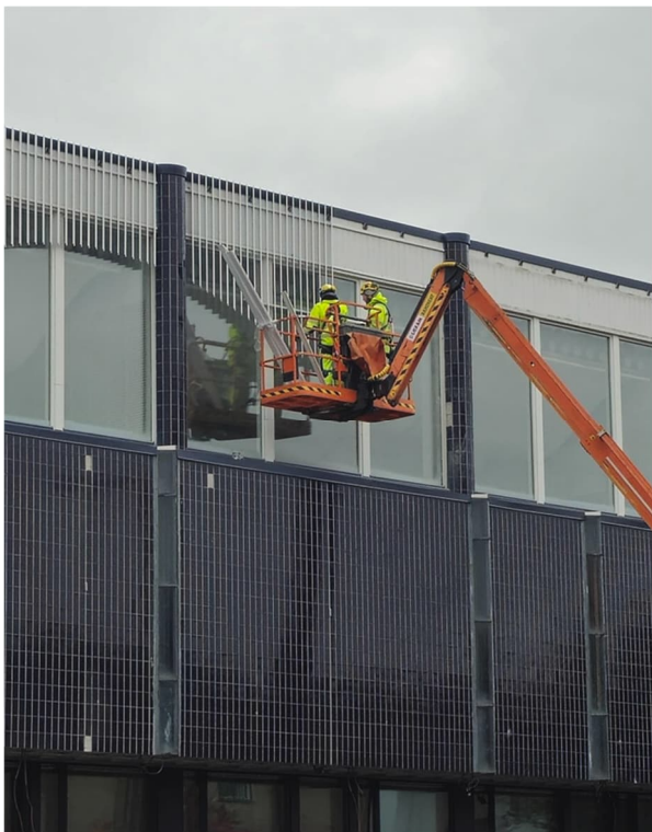
Kuvat 1 ja 2. Korjausosan julkisivun kunnostettujen säleikköjen asennus
