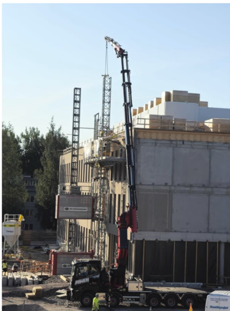
Kuvat 2. ja 3. Uudisosan mastolavojen purku- ja siirtotyöt
