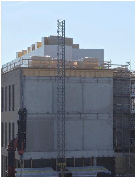
Kuva 1. Uusiosan vesikattotyöt käynnissä
