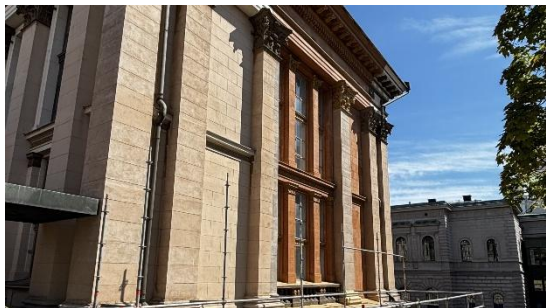
Kuva 1. Länsijulkisivu ennen töiden aloitusta.
