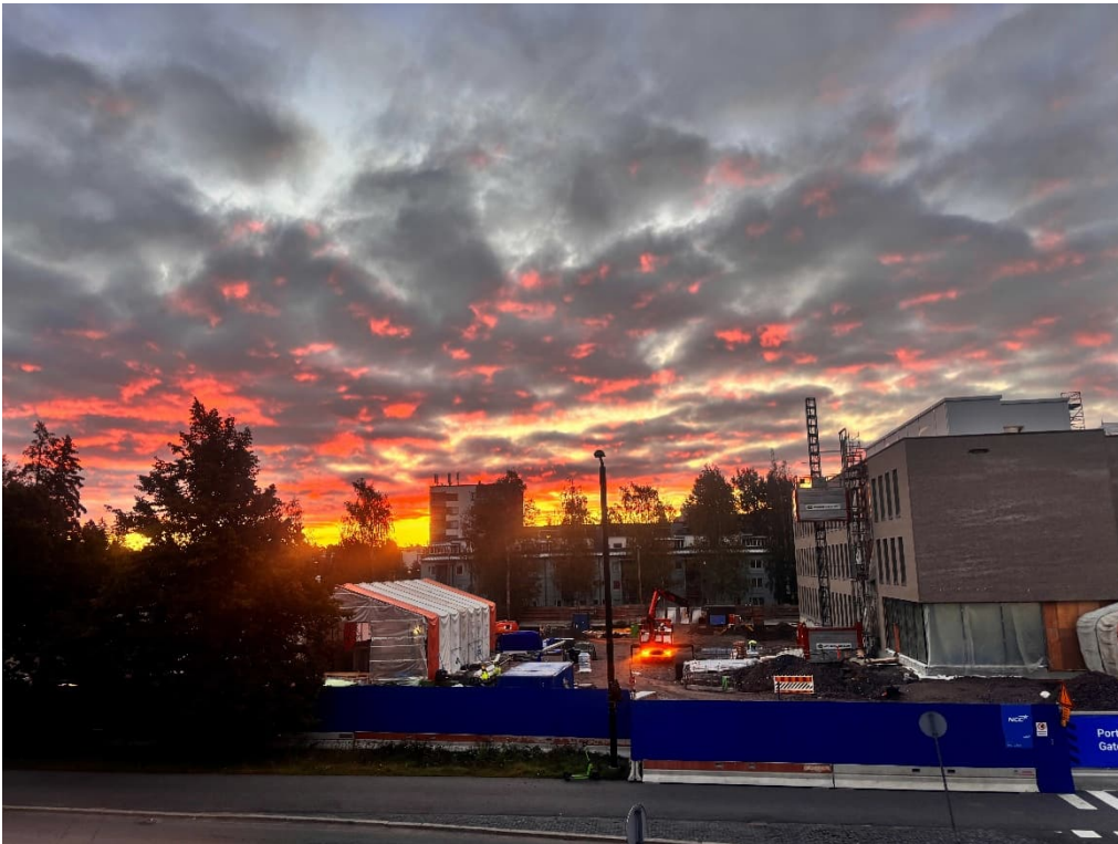
Kuva 1. Työmaalla aloitettiin työpäivät tällä viikolla monena aamuna upeissa auringonnousuissa.
