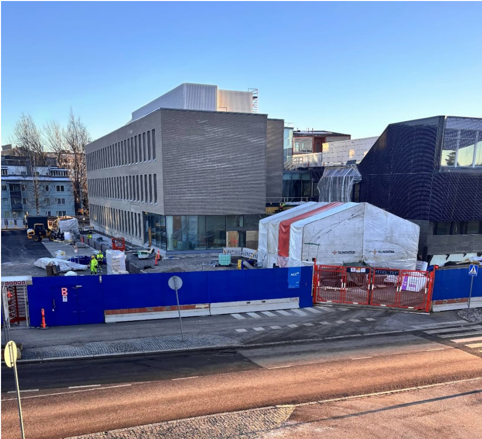
Kuva 1. Työmaalla on paljon työvaiheita käynnissä sekä uudis- ja korjausosalla sekä pihalla. Lumeton joulukuu on toistaiseksi suosinut pihatöitä.
