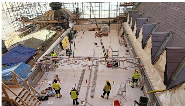
Kuva 2. Ristikko nostettu rullien päälle.
