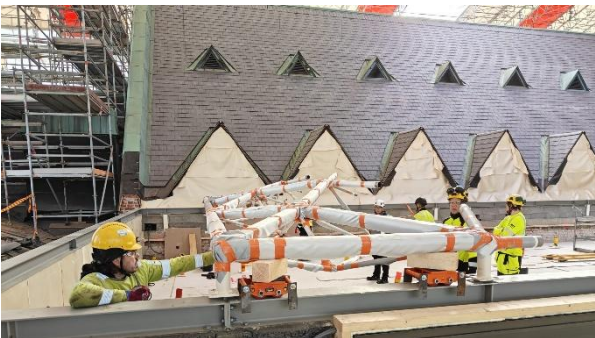
Kuva 3. Ristikon siirtoa oikealle paikalle.
