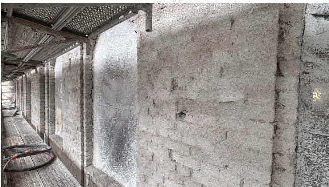
Kuva 5. Tartuntarappauksia Virastosiiven länsipuolella.
