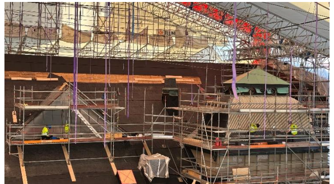
Kuva 6. Liuskekivien asennusta Virastosiiven porrashuoneessa.
