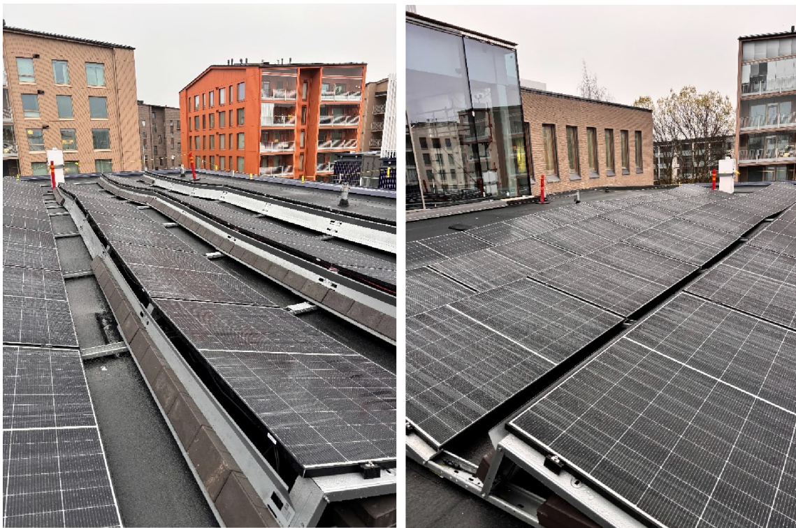
Kuva 1 ja 2. Aurinkopaneelit asennettu korjausosan katolle.
