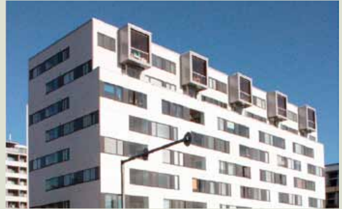
Housing Company Pasaatituuli in Helsinki, designed by Arkkitehtitoimisto Lahdelma ja Mahlamäki.
