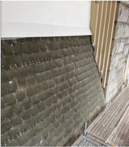
Kuva: Julkisivun liuskekivipenkki kivien irrotuksen jälkeen, oikealla penkin sijainti.
