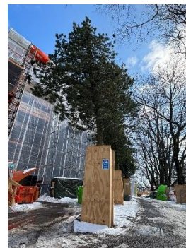
Kuva 3. Puiden suojaus.
