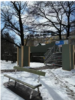
Kuva 1. Puiden suojaus.
