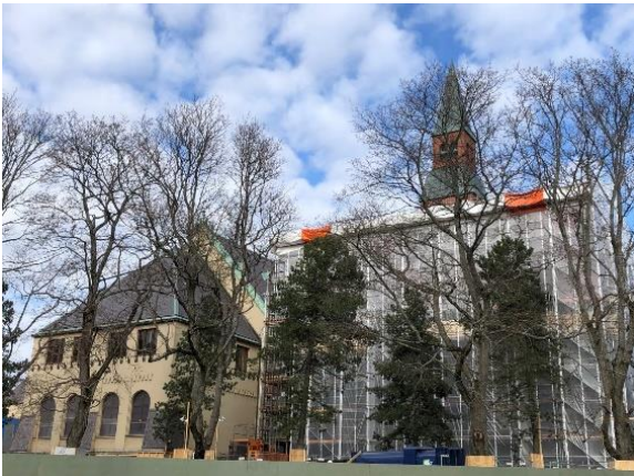
Kuva 6. Työmaa länteen Museokadun suuntaan.
