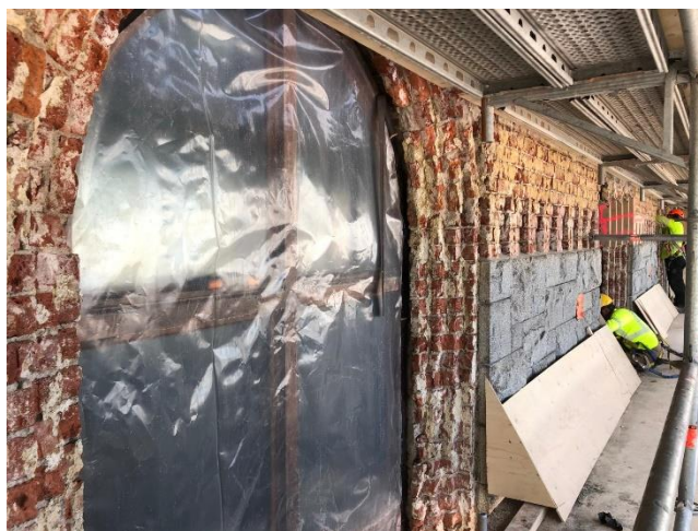
Kuva 4. Seinäpinta pesty rappauksen poiston jälkeen.
