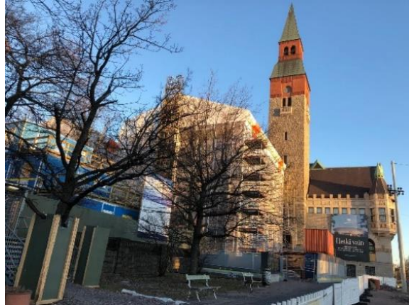
Kuva 7. Työmaa Mannerheimintien suuntaan.
