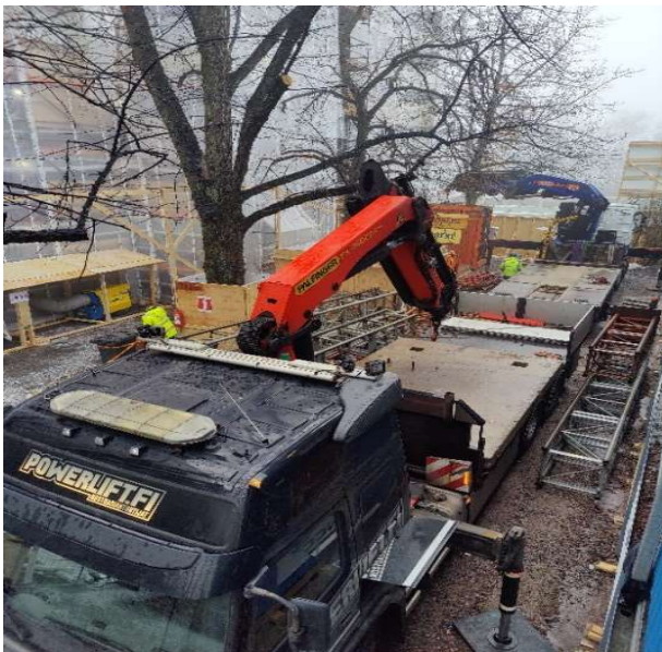
Kuvassa: Henkilötavarahissien paikalle kuljettamiseen ja asennukseen tarvittiin nosturiauto, tilanne 28.2.24.
