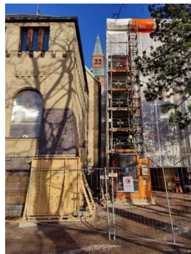
Kuvassa: Lohkon 1 itäisivun henkilötavarahissi asennettu.
