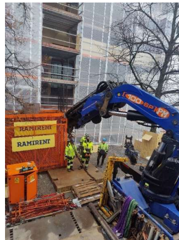
Kuvassa: Eteläpuolen henkilötavarahissin asennus käynnissä.
